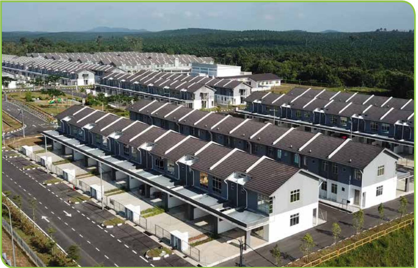
Residensi Kota Tinggi, Johor
